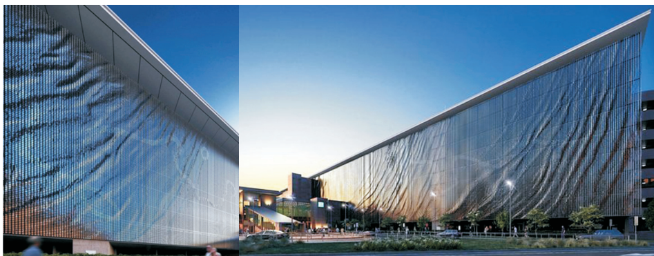
Рис. 6. Фасад паркинга в аэропорту Брисбена «Вертикальное озеро». Общий вид
