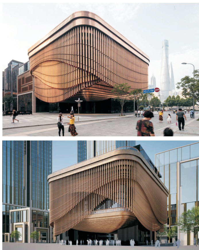
Рис. 5. Здание нового культурного центра в Шанхае. Общий вид
