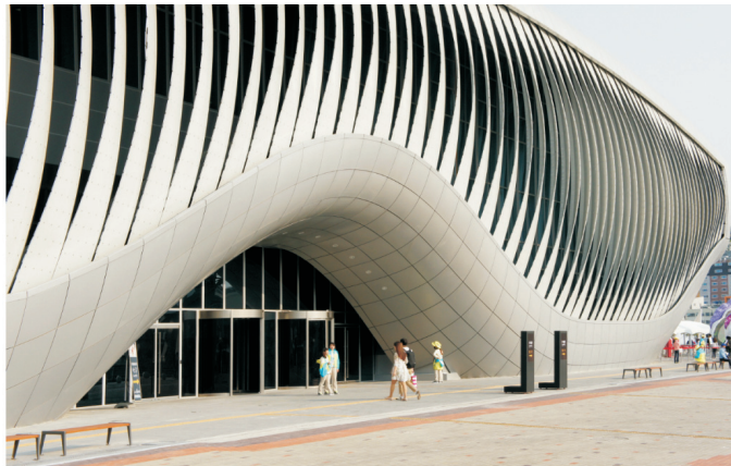
Рис. 3. Общий вид зданий Burke Brise soleil (а) и Ocean pavilion (б)
